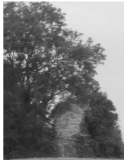
Vestige du château fort
